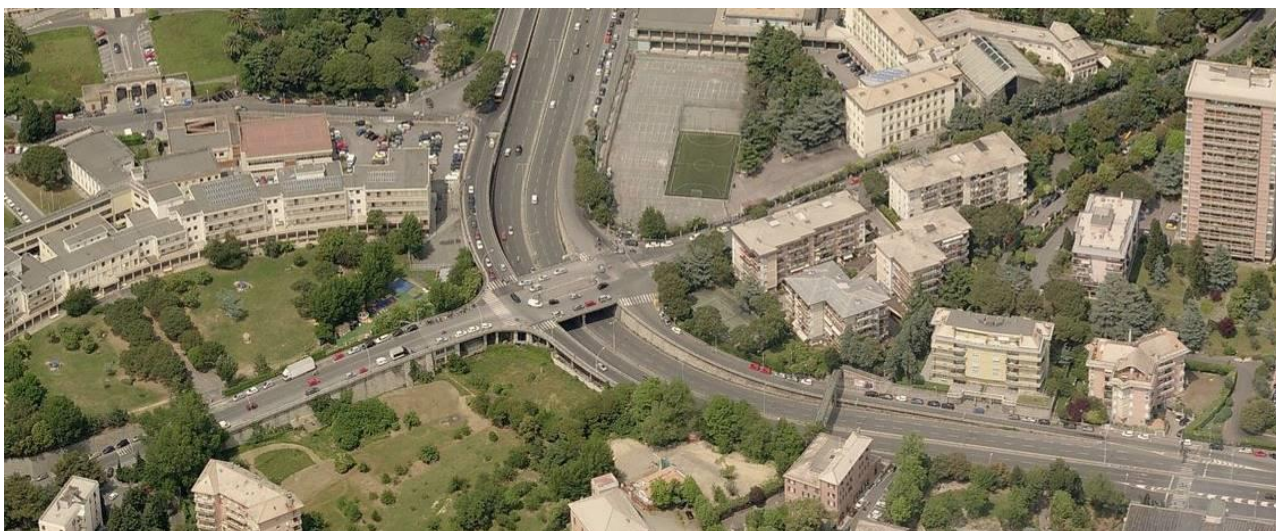
Figura 36: Vista aerea del cavalcavia di Via Carrara.
